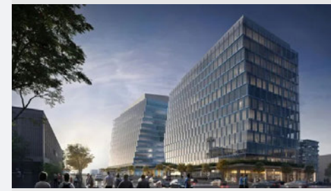
Mercer Mega Block 714 - 800 MERCER ST
