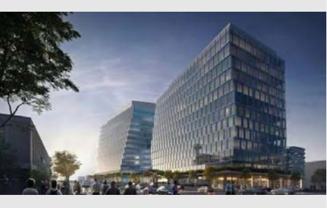
Mercer Mega Block 714 - 800 MERCER ST
